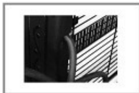
Kabel sa strane
